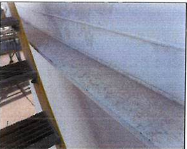
รูปที่ 16. Shell Stiffener Ring
